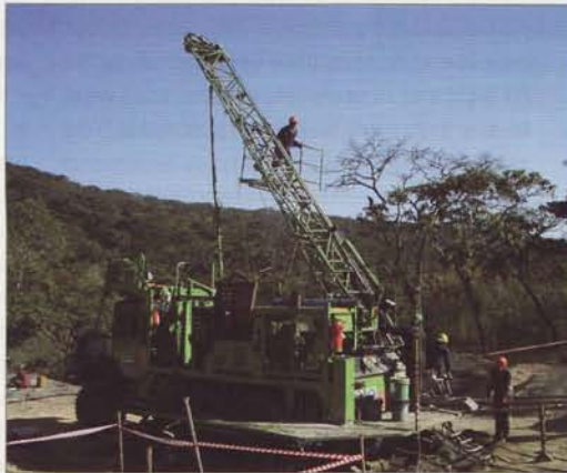
▲ Drilling at Kapulo.
